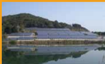
九州にて1MWの太陽光発電システムが完成
