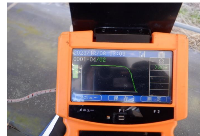
出力低下モジュール3 IVH測定
